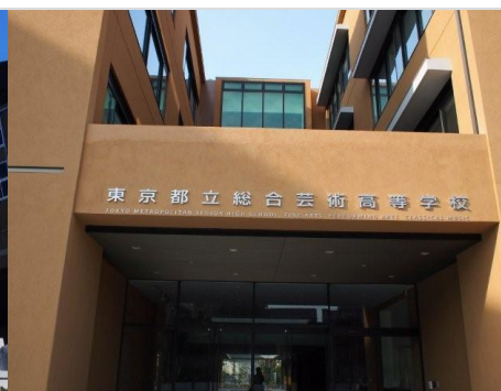
校舎棟正面玄関
